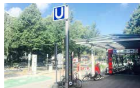
An der Hallerstraße wurde der jüngste „switchh-Punkt“ der Hamburger Hochbahn errichtet.
